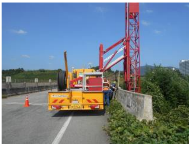
점검차량을 이용한 외관조사
