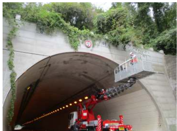
고소차량을 이용한 외관조사
